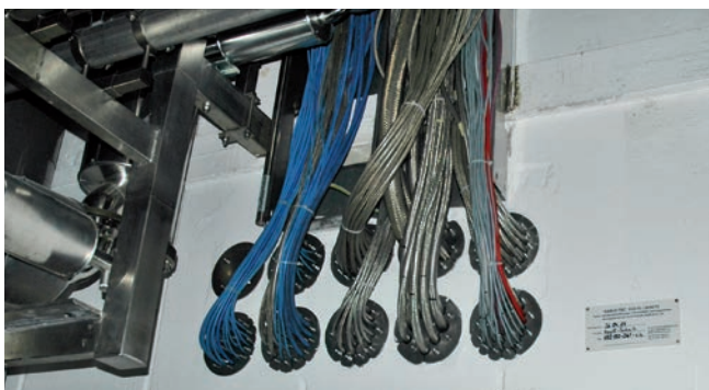
HRD 150-1G uszczelnienie wielu kabli w odwiertcie
