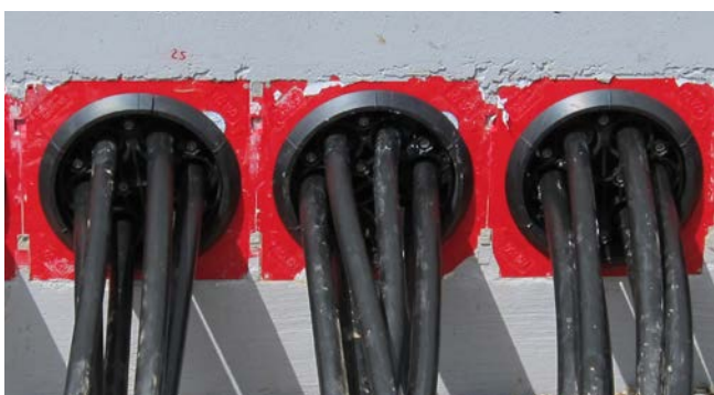
kable uszczelnione przy pomocy HSI 150-DG-6/10-36
