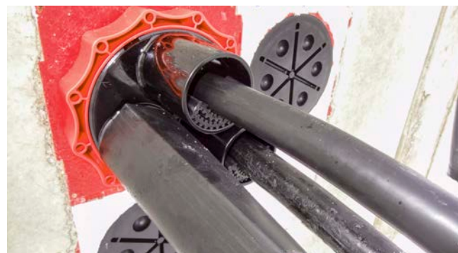
taśmy centrujące zamontowane wewnątrz króćców pokrywy HSI 150-D3/58
