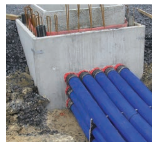
KES-M 90-D – uszczelnienie w przepustach kablowych HSI 90
