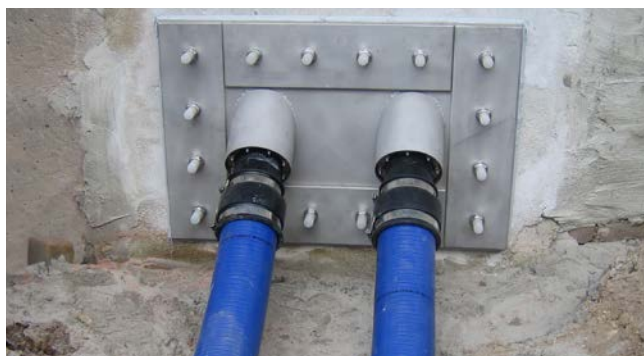
zastosowano kołnierz stalowy z ukośnym podejściem i gumowymi wkładami uszczelniającymi.
