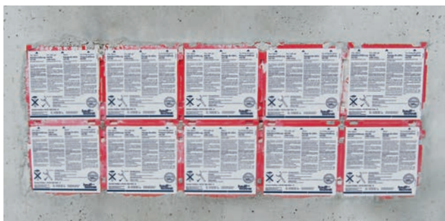
pakiet dwustronnych przepustów HSI 150 zamocowany w szalunku
