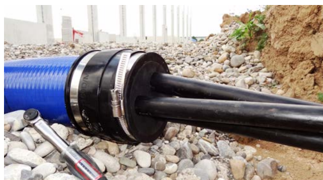
uszczelnienie w gruncie na końcu węża spiralnego Hateflex 14150 za pomocą zestawu uszczelniającego KES-M 150 WE 160-SG-3/22-54
