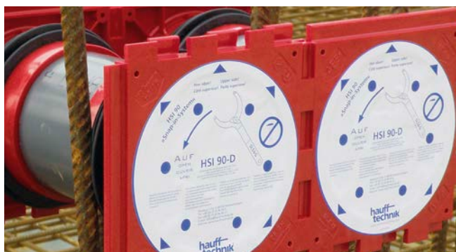
pakiet dwustronnych przepustów HSI 90 zamocowany w szalunku
