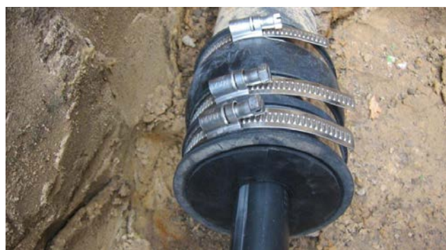
zestaw uszczelniający KES-M 90-WE100-SG-1/18-65 do uszczelnienia kabla na końcu rury osłonowej
