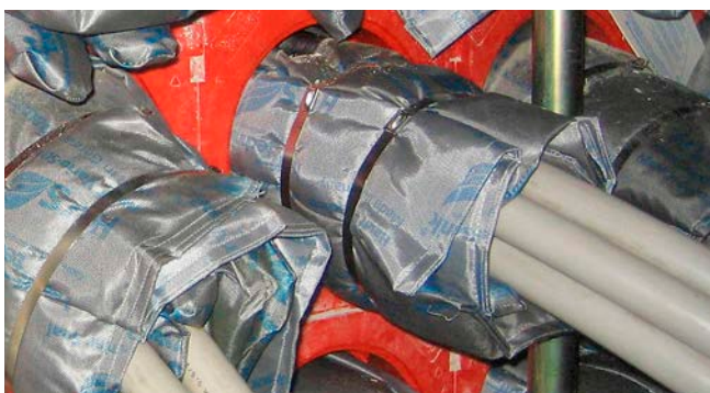
HSS – montaż poduszki przeciwpożarowej w przepuście do zabetonowania HSI 150-K2, uszczelnienie za pomocą pokrywy systemowej lub SEGMENTO
