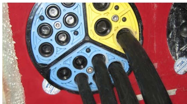
HSI 150 – SEGMENTO – ze zintegrowaną kontrolą momentu dokręcania i zaślepką
