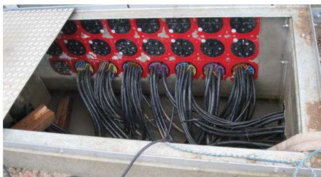
HSI 150 przepusty do zabetonowania wyposażone w uszczelnienie SEGMENTO do przewodów centrali sterowania
