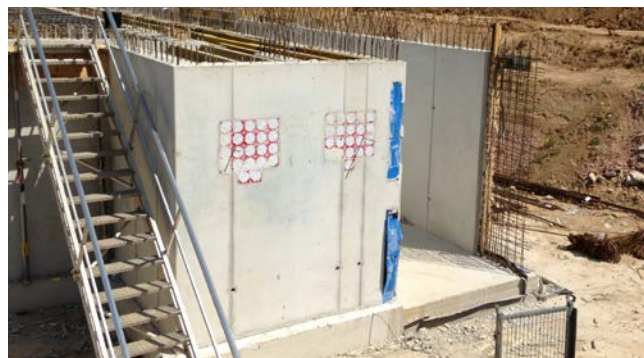
HSI 90-K2 po zabetonowaniu W tym miejscu przyłączy pustej rury
