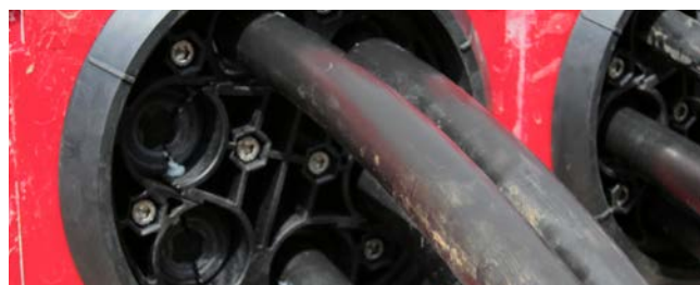
uszczelnienie kabli za pomocą pokryw HSI 150-DG
