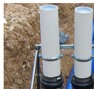
układ szeregowy 2x KES-M 150-ZVR 150/500 na stojaku KES-M ZVR-FUBO-Fix
