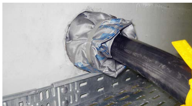
HSS – montaż w przewiercie z gumowym wkładem uszczelniającym HRD
