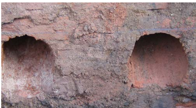
oworowanie kątowe ściany murowanej.
