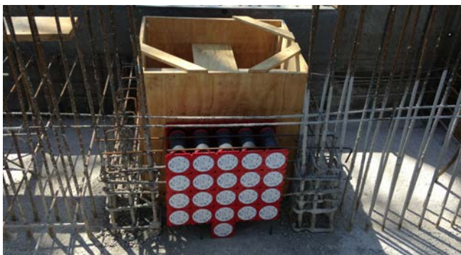
dwustronne przepusty kablowe HSI 90-K2 przed zabetonowaniem
