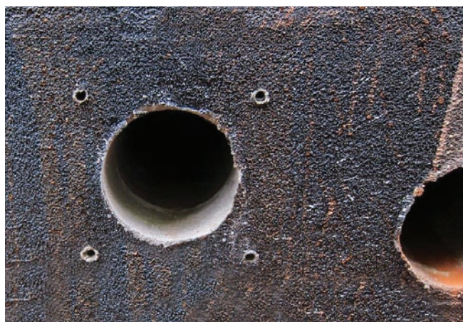
przewiert i otwory kołków rozporowych
