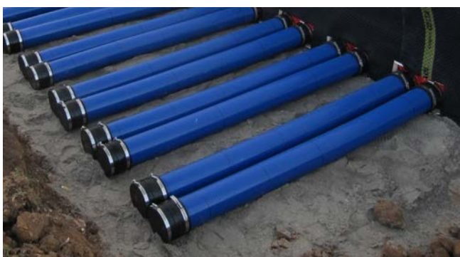
odporne na ciśnienie przyłącze węża Hateflex 14090 do przepustu do zabetonowania HSI 90 oraz zakończenie rury osłonowej
