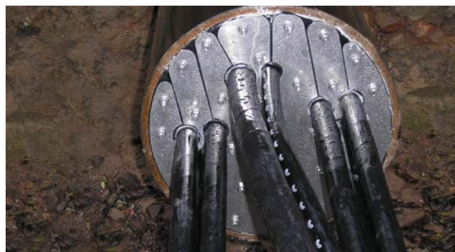
HRD 200-1G uszczelnienie w rurze stalowej
